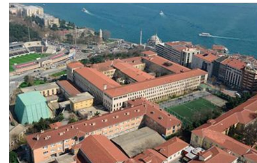
I.T.Ü Gümüşsuyu Binası
