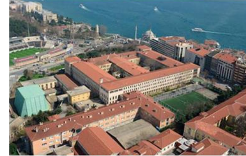
İ.T.Ü Gümüşsuyu Binası
