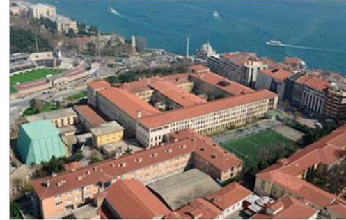
İ.T.Ü Gümüşsuyu Binası
